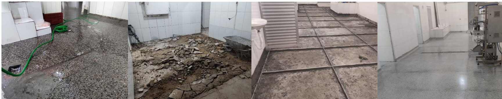
Fotos: Processo de remoção e aplicação de novo piso na unidade de beneficiamento da Cooperativa Grande Sertão em Montes Claros.
