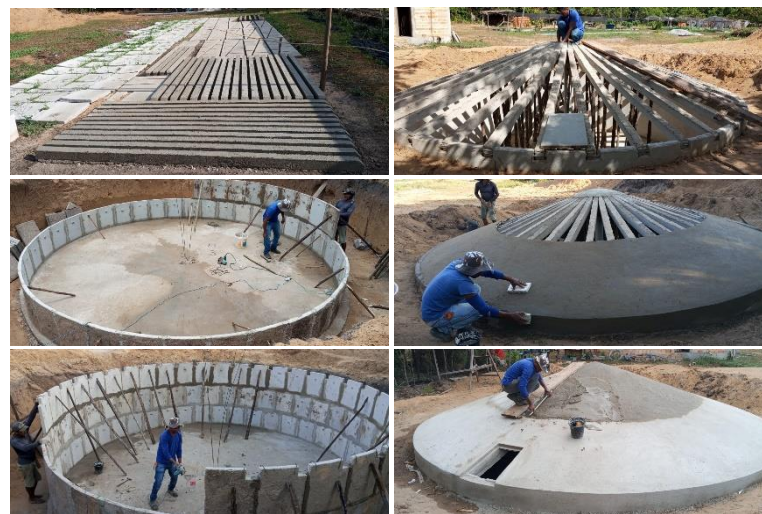
Fotos: Processo de construção das cisternas de placa para captação de água da chuva.
