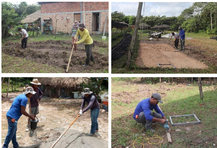
Fotos: Processo de construção de cisternas como parte prática do treinamento oferecido.
