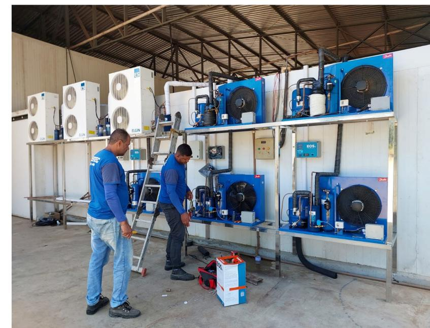
Foto: Equipamentos adquiridos para instalação da câmara fria, que será utilizada como unidade para armazenamento da polpa do cupuaçu.
